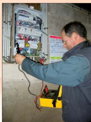
vérification des dispositifs différentiels
