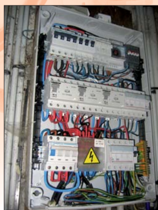
examen des circuits électriques
