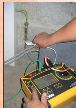
mesures des valeurs de la terre
